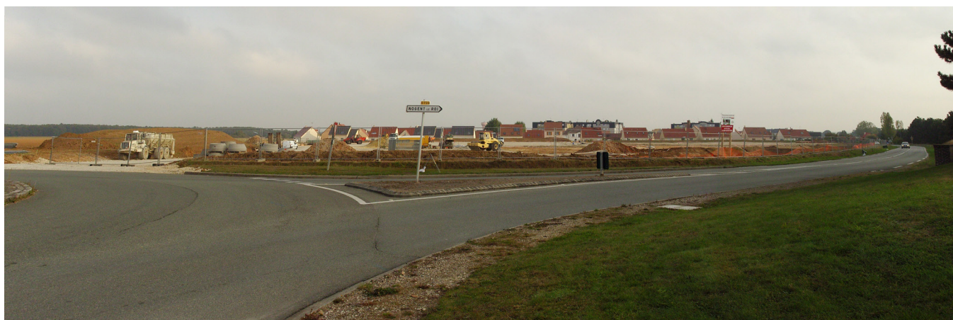
Entrée de ville , Nouvel intermarché en construction, Nogent le Roi
