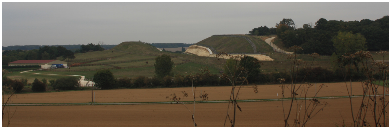
Intégration de la déviation par bouleversement de la topographie.
