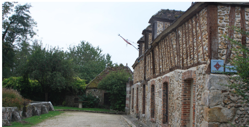
Assemblage de matériaux typiques de la région sur le moulin de mormoulin (brique, terre cuite, silex, roche calcaire, colombage.)
