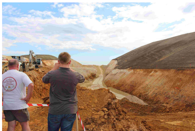
La déviation en chantier. Source : Nogent-le-roi.fr
