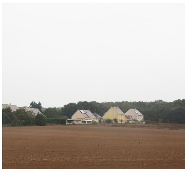
Nouvelles constructions en lisière de forêt refermant un peu plus l'espace boisé. Faverolles
