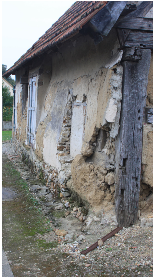
Grange à l'abandon constituée de torchis, colombages, et base de silex.
