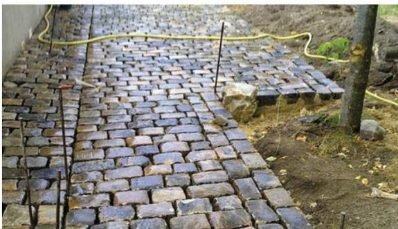
Exemple de traitement de sol en pavé avec joints de terre. La forme donnée au pavage et le fil d'eau permettent une bonne gestion de l'eau en pied de façade
