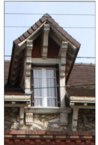
Épernon possède une grande variété de lucarnes, reposant autant sur les matériaux : charpente, maçonnerie ; que sur les formes. Les lucarnes les plus simples sont en bois. On remarque quelques lucarnes de type gerbière (accès au grenier). A partir du 17<sup>e</sup> siècle apparaissent les lucarnes à fronton (cintré ou triangulaire). La lucarne à croupe ou capucine du 19<sup>e</sup> siècle est plutôt en bois. Au 20<sup>e</sup> siècle apparaissent des modèles éclectiques souvent très ouvragés.
