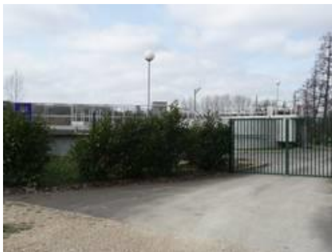
Station d'épuration à Mévoisins
