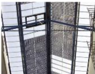
Les capteurs photovoltaïques sont intégrés à la verrière de la galerie de distribution d'une résidence HLM. L'île d'Abeau (Isère) © Photowatt
