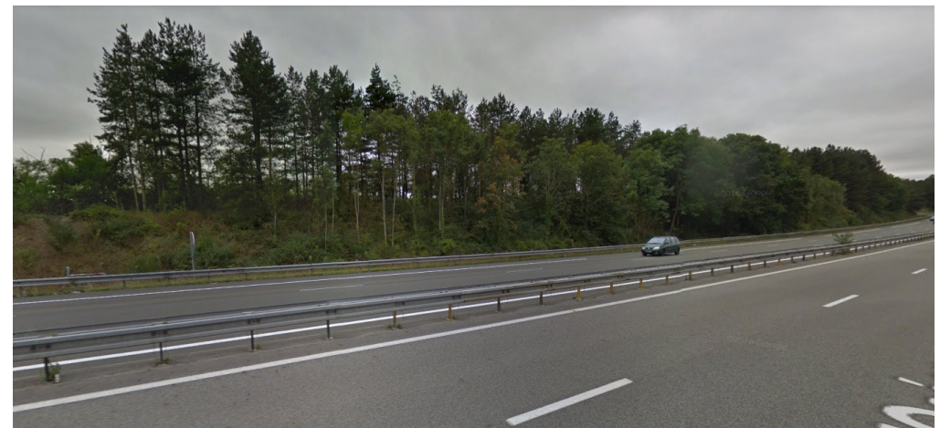
Bande végétale sur le talus en déblai entre l'autoroute et la parcelle accueillant les constructions (source google maps)
