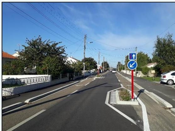
Le Chaucidou est une chaussée étroite sans marquage axial dont les lignes de rive sont rapprochées de son axe. Les véhicules motorisés circulent sur une voie centrale bidirectionnelle et les cyclistes sur la partie revêtue de l'accotement appelée rive. La largeur de la voie ouverte aux véhicules motorisés est insuffisante pour permettre le croisement, ces derniers empruntent donc la rive lorsqu'ils se croisent, en vérifiant auparavant l'absence de cyclistes.
