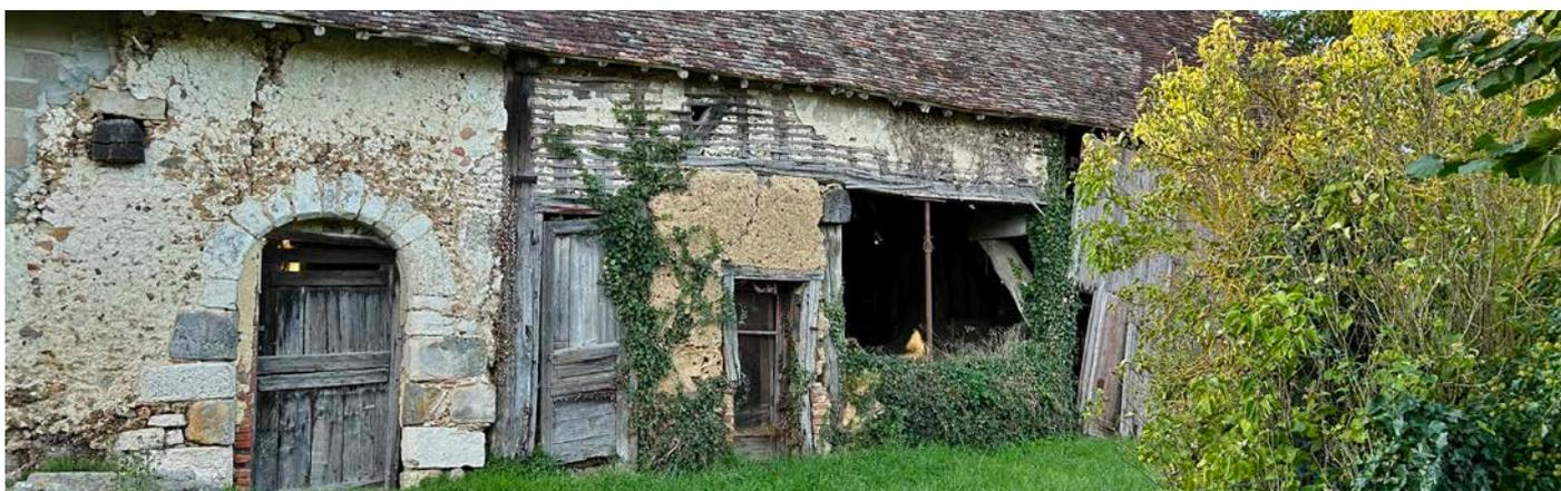
⚡ Maçonnerie mixte de silex et briques enduite à pierre vue, pierres de taille pour l'encadrement de porte en arc surbaissé. Saint-Laurent-la-Gâtine.
